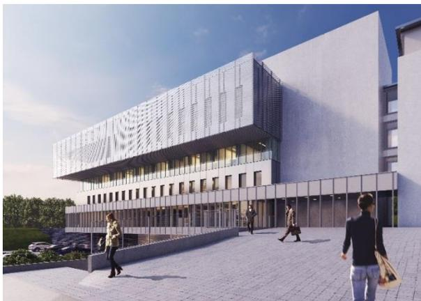
Ce nouveau bâtiment sera doté d'une structure en béton armé répondant à l'Eurocode 8 (risques sismiques) et sera habillé à l'extérieur par de l'aluminium sous plusieurs déclinaisons : caissons, panneaux pleins ou déployés et les châssis.
